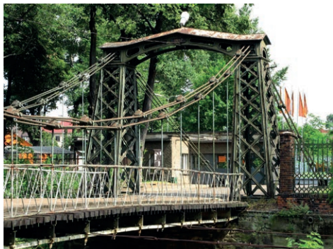
Widok ogólny mostu [2]
