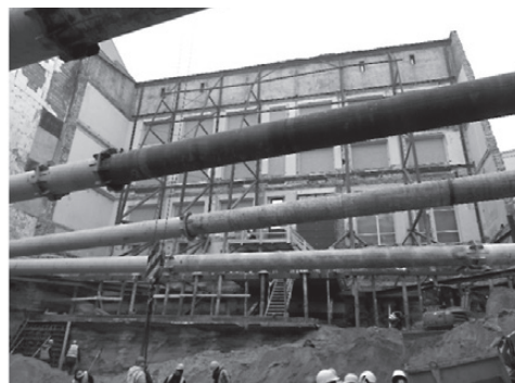
Rys. 6. Zrealizowane zabezpieczenie ściany frontowej (Pracownia Inżynierska Czesław Hodurek)
