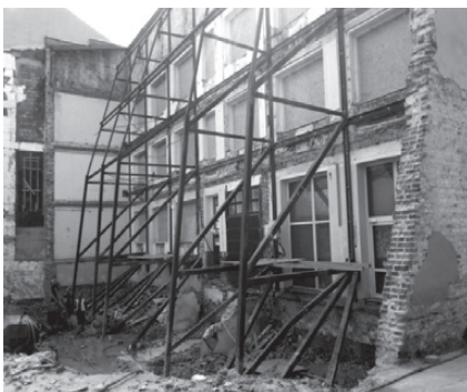
Rys. 6. Zrealizowane zabezpieczenie ściany frontowej (Pracownia Inżynierska Czesław Hodurek)
