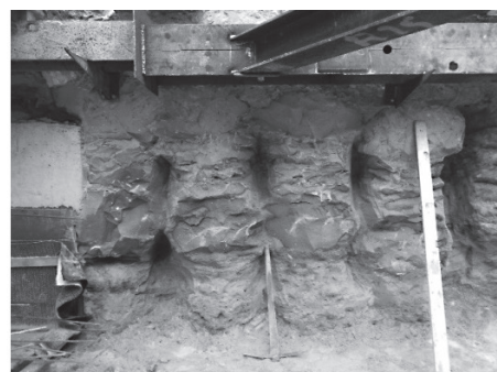
Rys. 7. Wykonywanie kolumn grunto-cementowych pod oficyną w ukośnych bruzdach oraz odkopane kolumny „jet-grouting” (Pracownia Inżynierska Czesław Hodurek)
