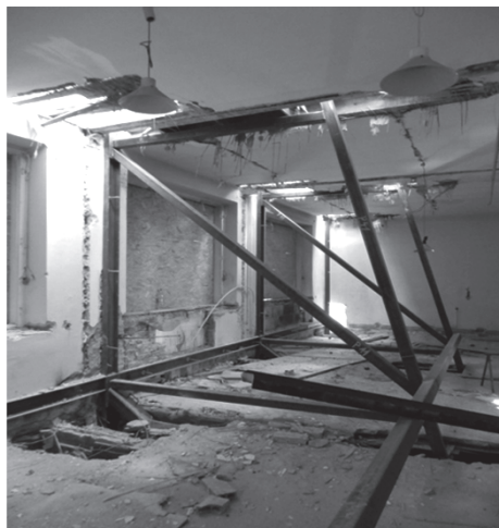
Rys. 5. Schemat zabezpieczenia ściany frontowej i montaż jej zabezpieczenia, widoczne przebicia w stropach (Pracownia Inżynierska Czesław Hodurek)
