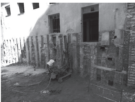
Rys. 7. Wykonywanie kolumn grunto-cementowych pod oficyną w ukośnych bruzdach oraz odkopane kolumny „jet-grouting” (Pracownia Inżynierska Czesław Hodurek)
