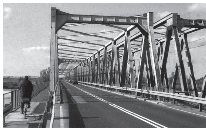
Rys. 1. Most przez Wisłę w Nagnajowie
