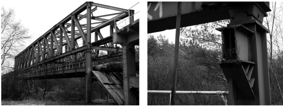
Rys. 5. Wycięte pręty podpory ramowej i prętów stężenia dolnego mostu technologicznego
