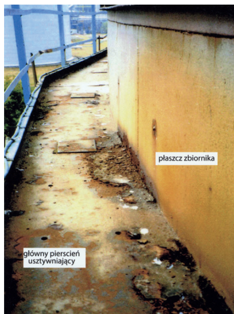
Rys. 3. Korozyjne uszkodzenia blach płaszcza zbiornika i spawanego z blach pierścienia usztywniającego
