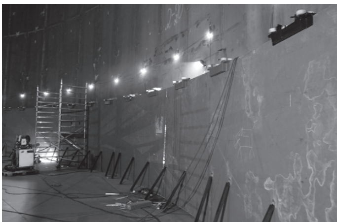
Rys. 3. Widok wnętrza zbiornika podczas montażu cargin dolnej. W górnej części są widoczne elementy rolek do posuwu blach (fot. firma Midroc Rodoverken AS)
