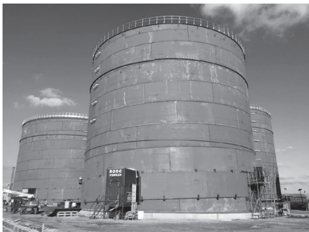
Rys. 1. Zbiorniki na paliwa płynne wznoszone metodą spiralną; Belgia 2017 r.
