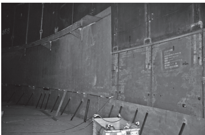
Rys. 4. Montaż górnej warstwy blach wraz z usztywnieniem dachowym (fot. firma Midroc Rodoverken AS)
