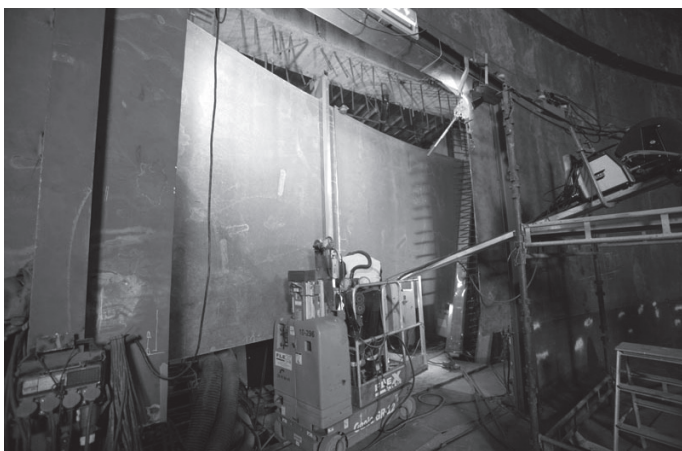
Rys. 8. Okno montażowe umożliwiające komunikację, wraz ze stanowiskiem do spawania wewnętrznych spoin pionowych (fot. firma Midroc Rodoverken AS)
