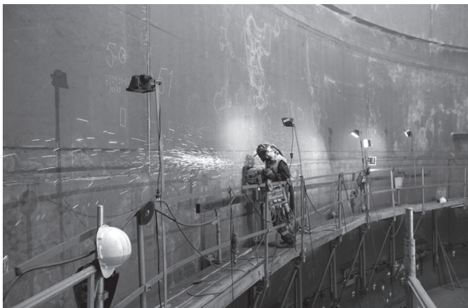
Rys. 7. Stacjonarne rusztowania do spawania wewnętrznego obwodowego, szlifowania spoin, sterowania obrotem i wykonywania badań nieniszczących (fot. firma Midroc Rodoverken AS)
