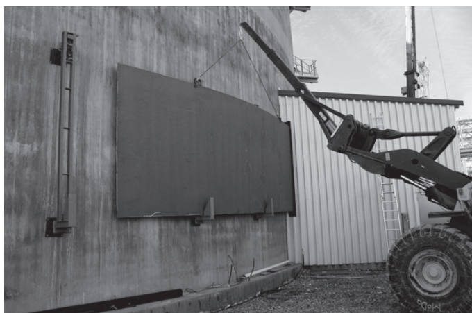
Rys. 6. Układanie blach do spawania wstęgi na zewnętrznych uchwytach (fot. firma Midroc Rodoverken AS)
