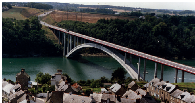
Rys. 2. Most Chateaubriand w czasie wysokiego poziomu wody
