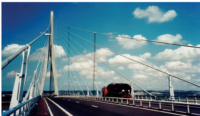
Rys. 12. Most Normandzki – układ latarni na watach
