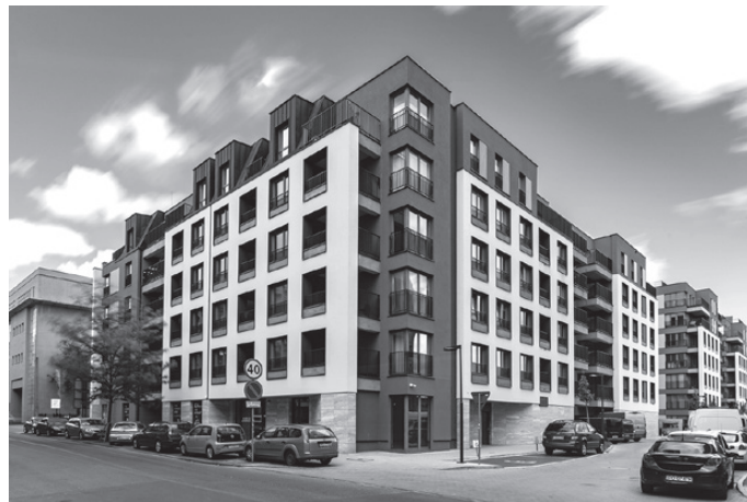
Rys. 4. Budynek mieszkalno-usługowy wielorodzinny z podziemną halą garażową w Poznaniu
