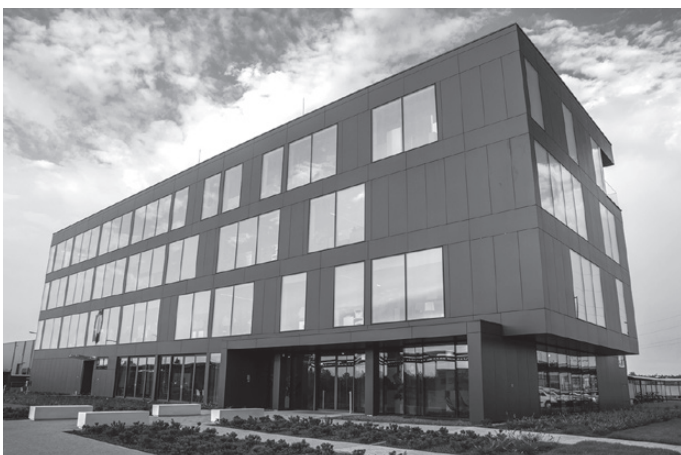
Rys. 11. Hala magazynowa budynku biurowo-produkcyjnego w Częstochowie
