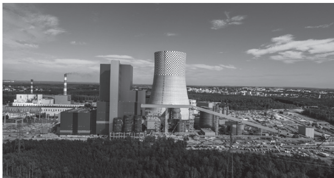
Rys. 13. Chłodnia kominowa w Elektrowni Jaworzno III – Elektrownia II
