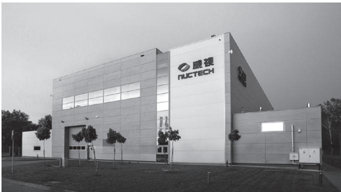
Rys. 10. Budynek produkcyjno-magazynowy przy ul. Napoleona 2 w Kobyłce
