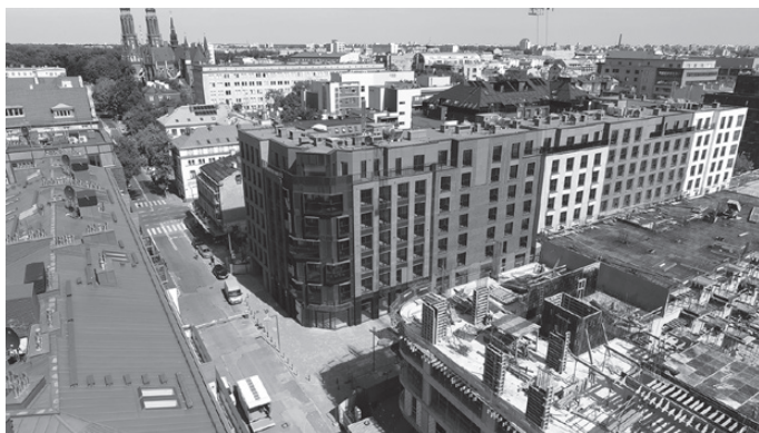
Rys. 3. Budynek mieszkalny wielorodzinny Sierakowskiego II w Warszawie
